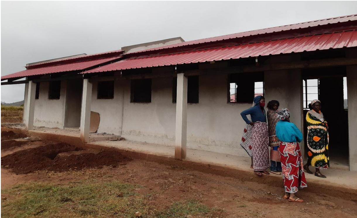
Nach den Erfahrungen durch den Zyklon IDAI werden alle Schuldächer in einer neuen Bauweise angebracht: Die Dachfläche an der Eingangsseite wird nicht mehr am Stück aufgelegt, sondern die Überdachung der Laufwege, unter der der Sturm eine gute Angriffsfläche findet, wird von der restlichen Dachfläche abgetrennt, so dass nicht gleich das komplette Dach wegfliegt.
